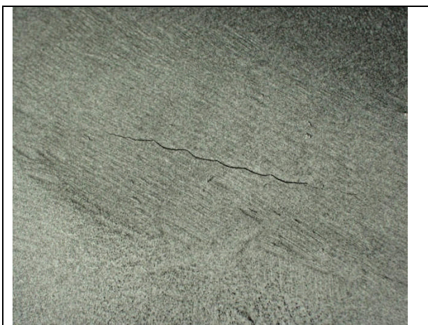
1. ábra – Tartály belső falán roncsolásmentes eljárással feltárt indikáció Figure 1 – Indication found by NDT on the inner surface of a vessel
