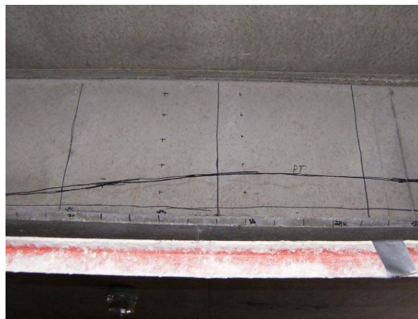
Betongerenda repedéseinek vizsgálata.
