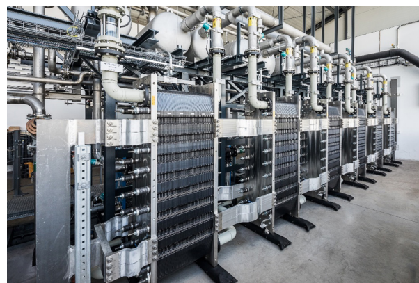
4. ábra: A H2Future berendezés a voestalpine linzi telephelyén [12]: (a) az épület, (b) az elektrolízis berendezés (Siemens)
